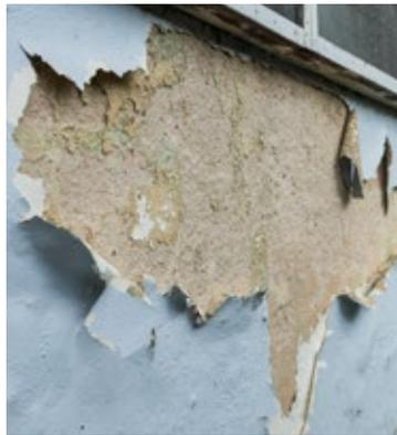
Eliminar con acción mecánica restos de pintura o partes del soporte mal adheridas.
