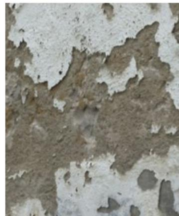
Eliminar con acción mecánica restos de pintura o partes del soporte mal adheridas, aplicar:
